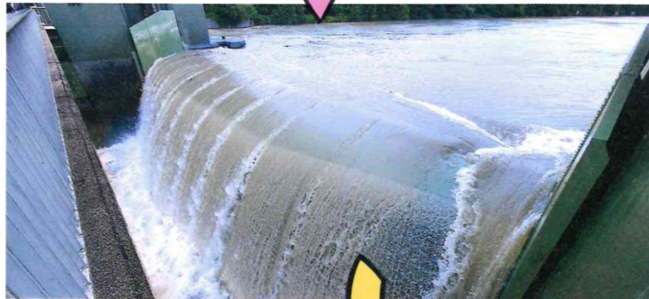
Bild oben: Der Rhein wird bei Birsfelden gestaut. Rechts im Bild befindet sich das Maschinenhaus. Dort stürzt das Wasser auf die Turbinen.
